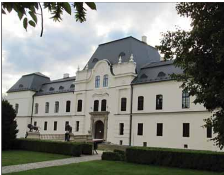
Kaštieľ v Humennom dostal po rekonštrukcii ešte príťažlivejší vzhľad.
