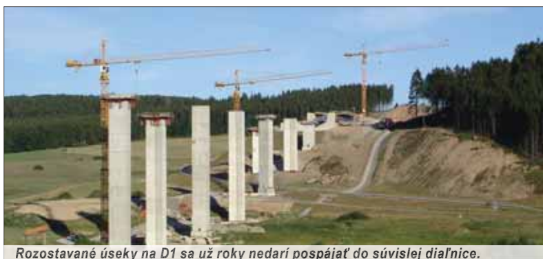
Rozostavané úseky na D1 sa už roky nedarí pospájať do súvislej diaľnice.
