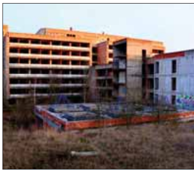
Nemocnicu na Rázsochách v Bratislave začali stavať ešte v roku 1985. Po rozbehu ju dotiahli do vysokého stupňa rozostavanosti, potom akoby uťal, dokonca sa uvažuje o jej zbúraní...
