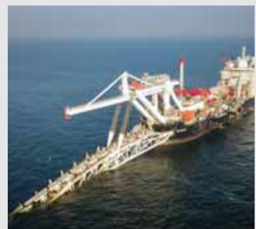
Výstavba plynovodu Nord Stream
