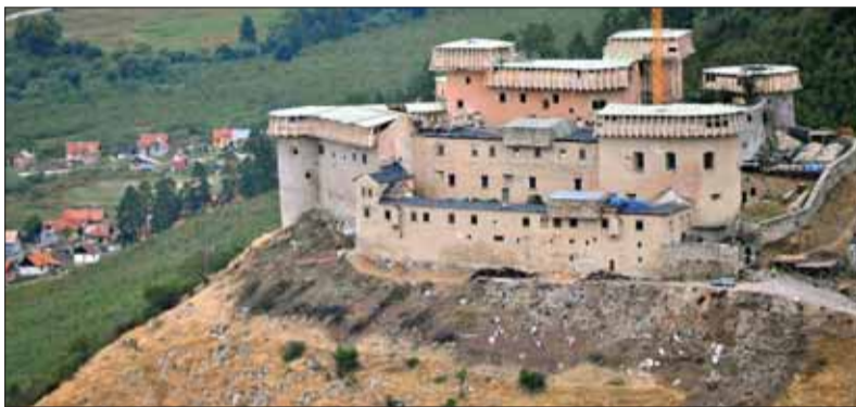
V sobotu 10. marca 2012 ničivý požiar, ktorý založili neopatrní malí osadníci z Krásnohorského Podhradia, zachvátil najkrajší zachovalý stredoveký hrad na Slovensku a premenil ho na žalostné ruiny, ktoré ani desaťrocie opráv a značných finančných injekcií nedokázalo vrátiť do pôvodného stavu.
