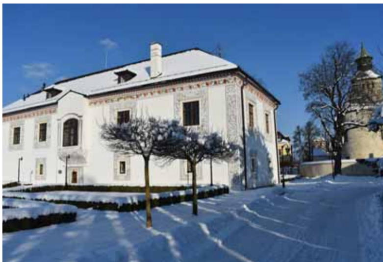
Sobášny palác, ktorý dal Juraj TURZO vybudovať na svadby svojich siedmich dcér, bol pred rokmi v žalostnom stave. Precízna pamiatková obnova vrátila tomuto výnimočnému renesančnému objektu pôvodnú vznešenosť a krásu.
