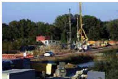
Výstavba diaľničného obchvatu cez rieku Dunaj
